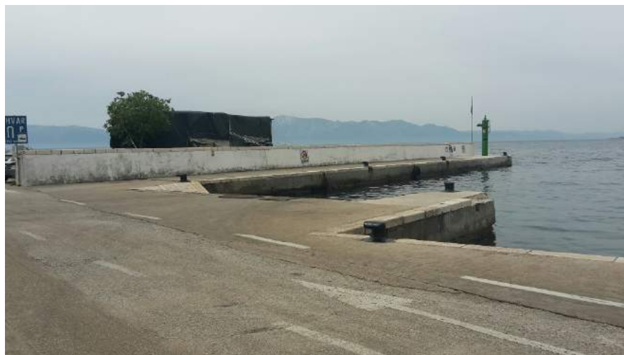
Slika 3.1.-2.: Postojeće trajektno pristanište
